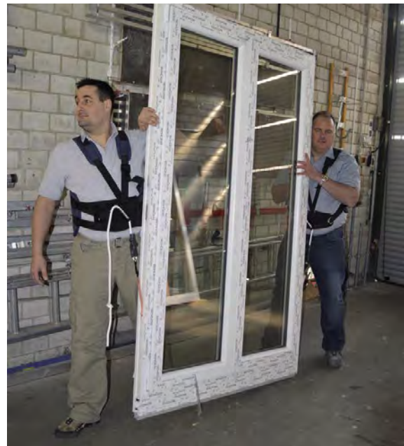
Abb. 3.4.5-04 Transport mit Hilfe von Tragegurten
