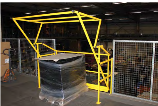
Abb. 3.4.3-05 Sicherheitschleuse für Lagerbühne
